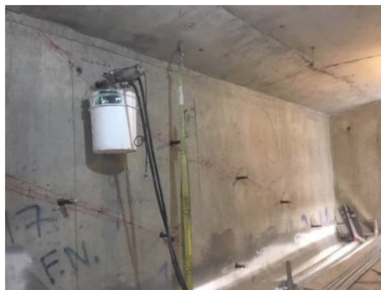
Bơm chất ức chế ăn mòn bằng thiết bị siêu âm
